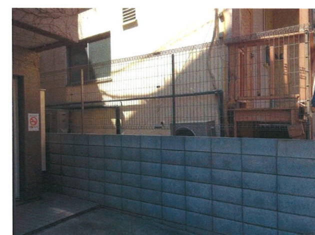
五反田外構工事
