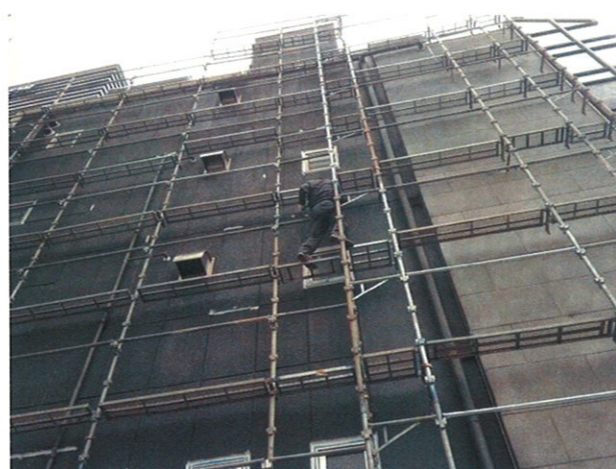
南平台外壁塗装
